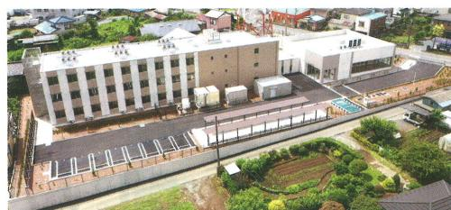
SAM工法で建てた社員寮。コンクリートの両面を断熱材でサンドした厚い壁の構造により、断熱性だけでなく、遮音性や耐震性、耐火性、耐久性にも優れている
