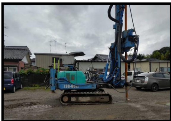
GNSS 受信機の取付(写真①)
