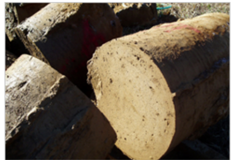
セミパイル掘り出し状況
