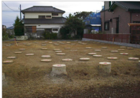
施工完了状況
