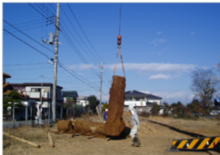
セミパイル掘り出し状況
