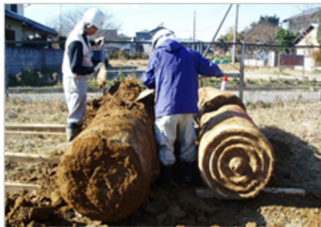
セミパイル掘り出し状況
